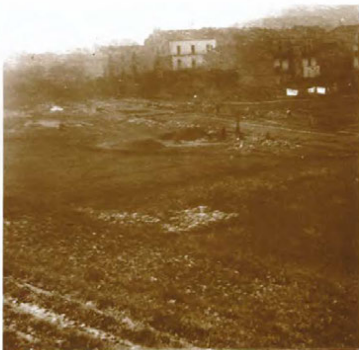
Primers treballs de fonamentació al solar on s'estava construint el grup escolar. La fotografia fou realitzada cap a finals de 1927.
